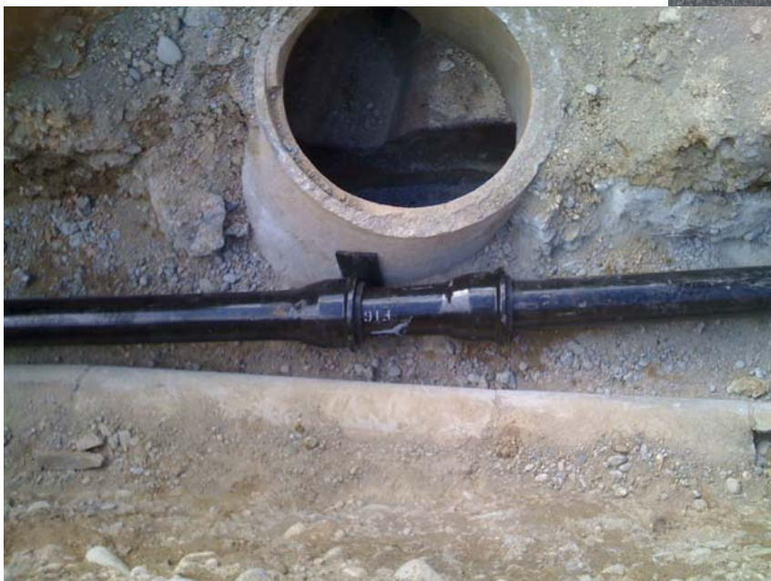
Platzverhältnisse in der Bellvuestrasse ( Kanalisationsschacht wurde bei den Bauarbeiten „entdeckt“ )
